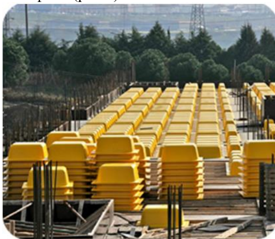
Рисунок 1 – Загальний вигляд опалубки для кесонного монолітного перекриття
