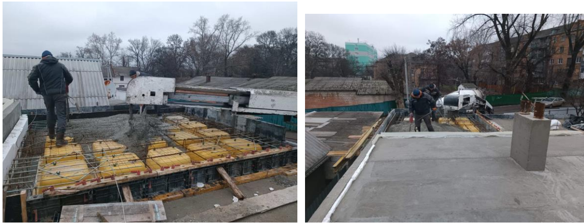
Рисунок 2 – Бетонування кесонного монолітного перекриття на об'єкті ТОВ «Будспектр»
