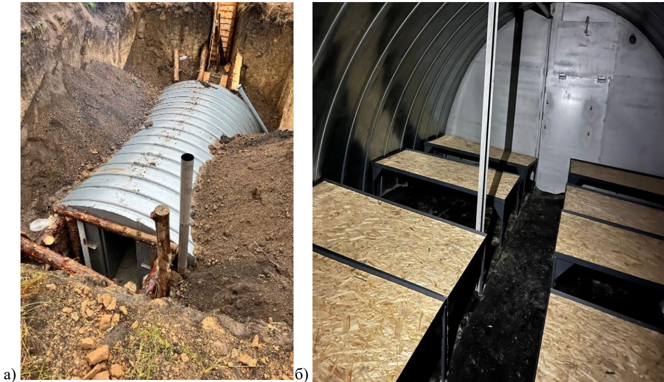
Рисунок 2 – Металеве бункер-сховище: а) монтаж, б) вигляд всередині
